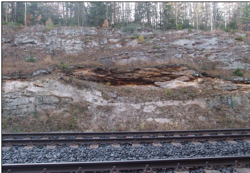
Obrázek 7 - čelní pohled na partii s vyvětranou dutinou s převisem v km 203,200
