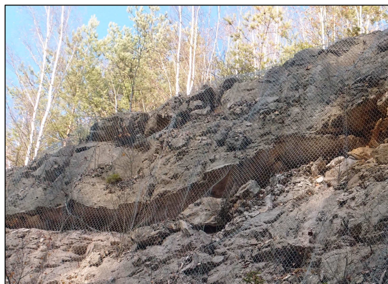
Obrázek 10 -pohled na převislé místo v pravé stěně v km 203,600. Patrné je rozevření nespojených sítí a akumulace sutí i velkých bloků, které hrozí vysypáním.
