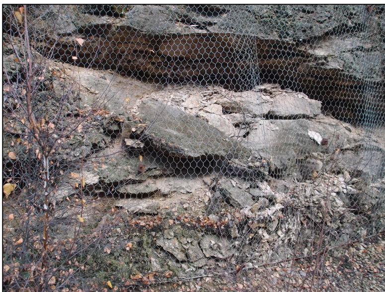
Obrázek 13 -příklad převisu v patě svahu (cca km 203,600), kde je zřejmé, že fixace obturátory nemůže mít úspěch a vliv na stabilizaci uvolněných hornin, natožpak na stabilizaci převisu jako takového.
