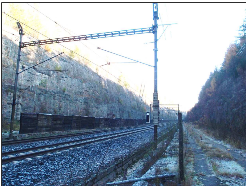
Obrázek 8 - pohled proti směru staničení do oboustranného zářezu z konce úseku v km 204,000. V popředí patrné zachytivé bariéry a udržovací prostory.
