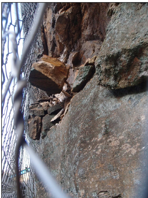
Obrázek 3 - pohled na vytržený ocelový trn i s kusem horniny, jež spočívá na volně vyvěšené síti v km 202,980–202,300
