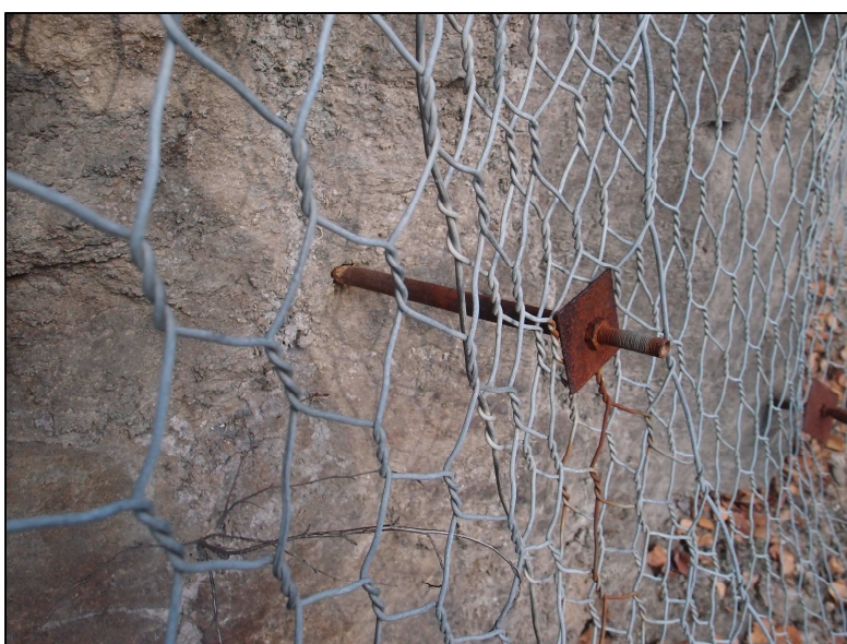
Obrázek 12 -delší obturátor (40 cm), který po instalaci z poloviny vyčnívá ze skalní stěny a je tak snížena jeho fixační schopnost.
