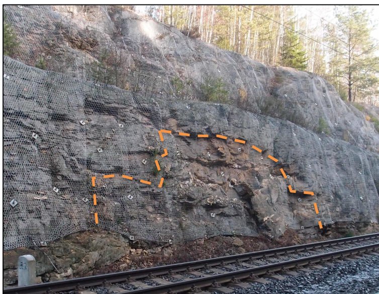
Obrázek 2 - pohled na porušené sanační opatření sítěmi v km 202,980–202,300 se zvýrazněním stávajícího okraje porušení
