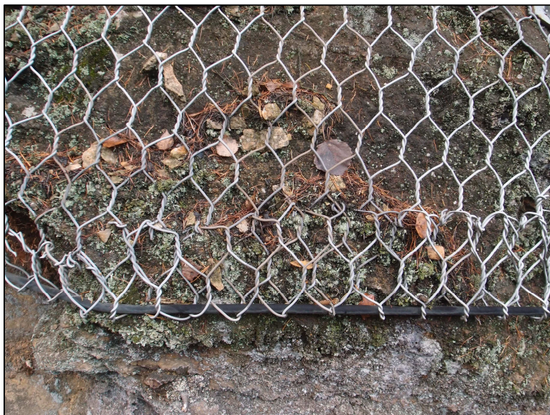
Obrázek 5 - nedostatečný přehyb sítě na spodním okraji sítě, který zároveň není opatřen spojením drátěnými svorkami (přehyb je zajištěn pouze zahnutím konců drátů sítě).
