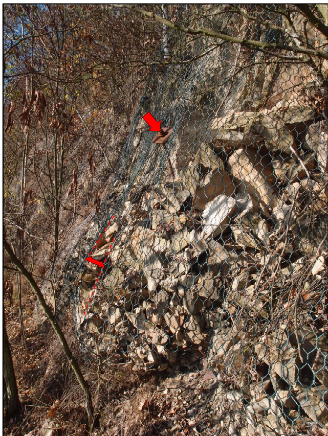
Obrázek 15 -pytlovitá akumulace sesutých horninových úlomků. Je vidět jednak vytržený trn a jednak rozevření nezašitých pásů sítě pod ním vlevo.
