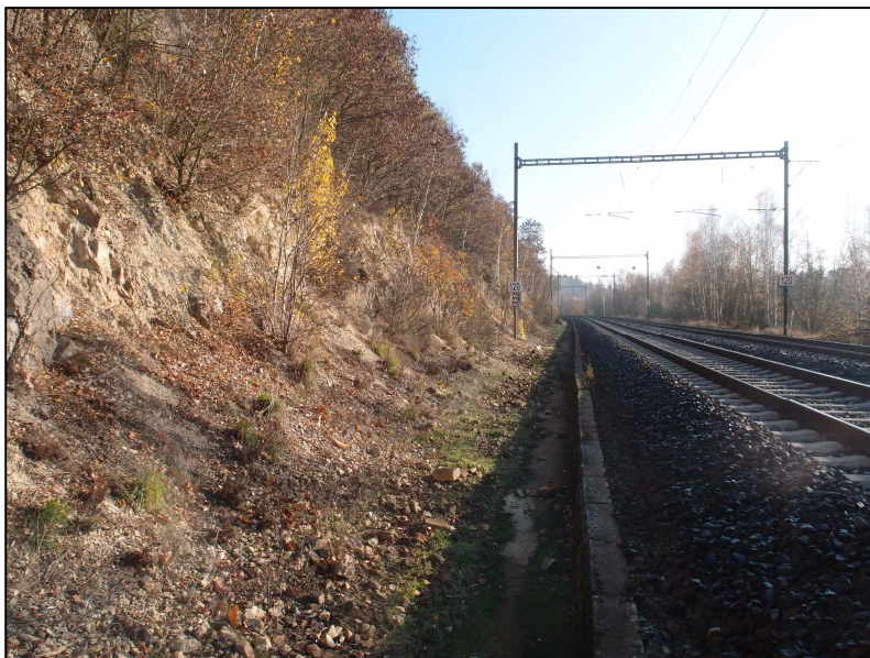
Obrázek 14 -pohled proti směru staničení z km 204,900 na spodní část svahu s otevřeným odvodňovacím zařízením. Pod stěnou patrný opad ze sítí nezakryté části stěny.
