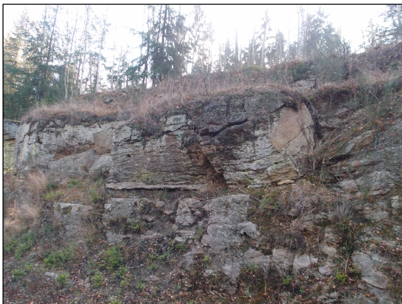
Obrázek 6 –čelní pohled na dva oddělené bloky těsně pod subhorizontální lavicí ve skalní stěně v km 202,830–202,835.
