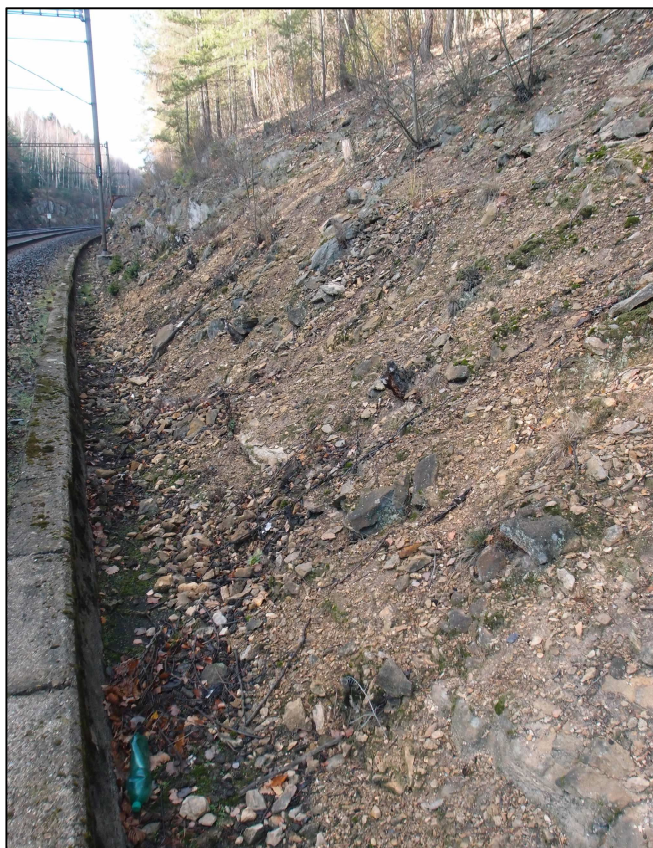
Obrázek 1 -pohled ve směru staničení na odvodňovací zařízení a sešlapaný svah nad ním v úseku km 202,600–202,700.
