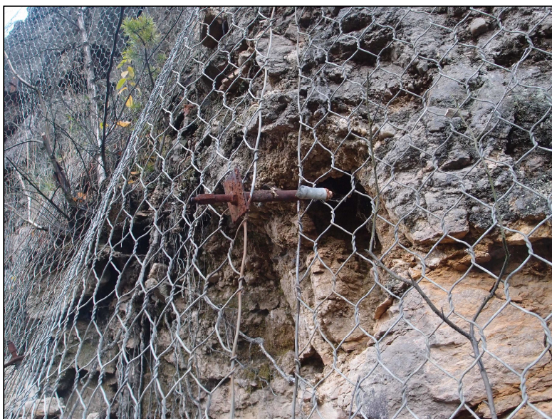
Obrázek 11 -typická ukázka obturátor, v tomto případě o délce 20 cm, který po vytržení spočívá zcela bez funkce v síti, jež se bez spojení drátěnými svorkami rozvírá a nefunguje.
