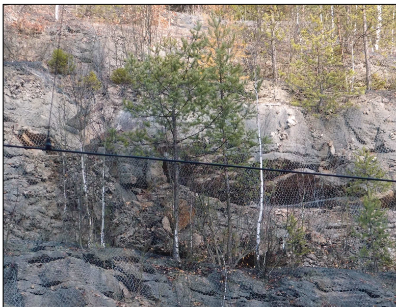
Obrázek 9 -pohled na převislé místo, kde došlo k opadu hornin, jež jsou sice dosud zachyceny v sítích, ale vzhledem k absenci spojení jednotlivých pásů sítě a omezenému účinku fixace sítě ke skalní stěně obturátory to nemusí být stav trvalý (pravá strana zářezu nad druhou bermou v km 203,650)
