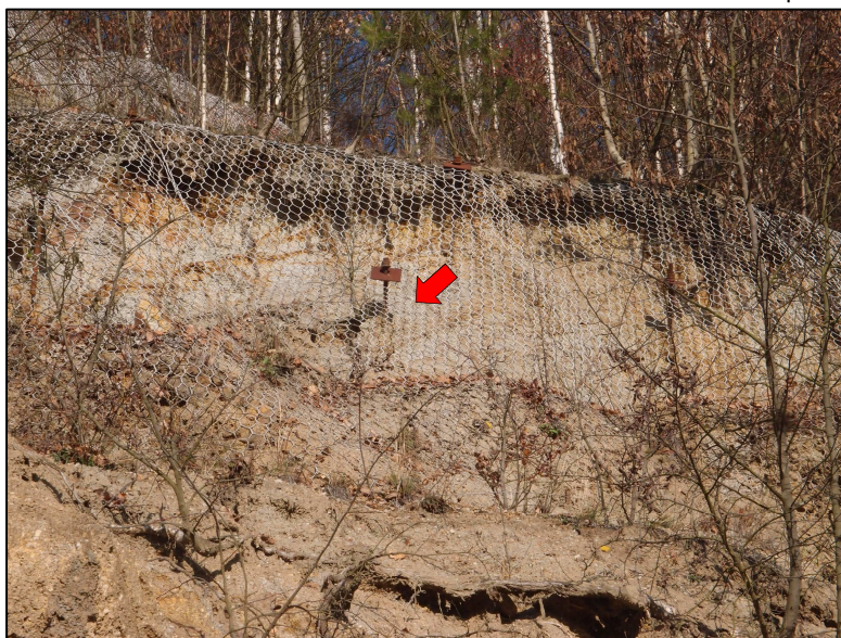
Obrázek 16 -prázdné prostory mezi sítí a skalní stěnou, vzniklé propadem písčitých reziduí skrz síť. Došlo tak k obnažení účinné délky trnů a při pádu větších akumulací hmot sítě může být síť i s trnem vytržena.
